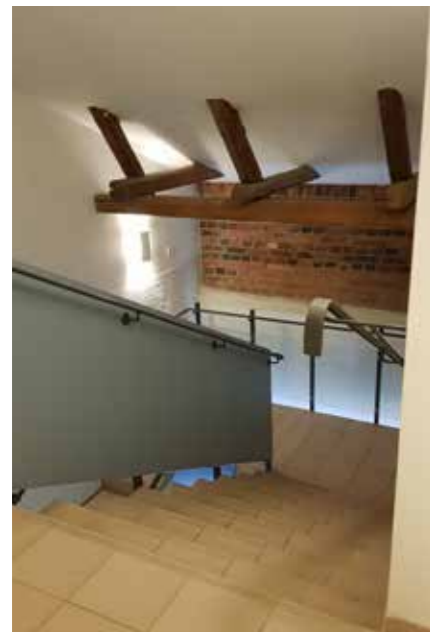
Puurakenteita näkyvillä Kalanterin ullakokerroksessa. Hanna Lyytinen 28.5.2019, Arkkitehtitoimisto Hanna Lyytinen Oy.
