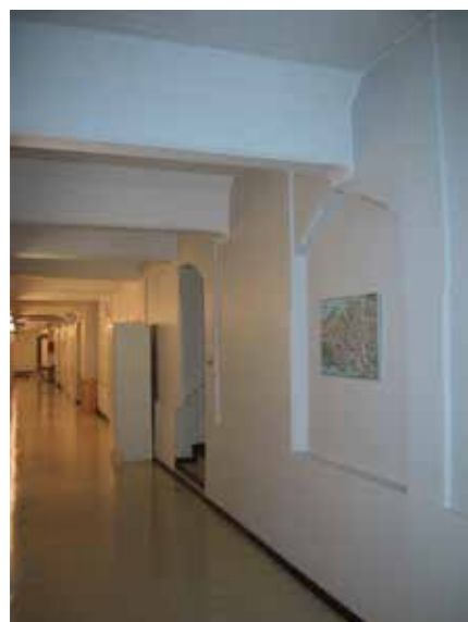
A-siipirakennuksen, nk hollanterisiiven pihan ja koskenpuoleisten eri-ikäisten rakennusosien välillä on tiilimuuri 1800-lu-vulta, joka kantaa 1900-luvun alun uusia betonirakenteita. Kuva vuodelta 2000, Arkkitehtitoimisto Hanna Lyytinen Oy.
