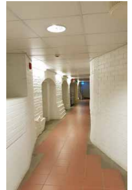
Kalanterin kellarin rakenteita 2019. Vanhoja rakenteita on vahvistettu. Hanna Lyytinen 28.5.2019, Arkkitehtitoimisto Hanna Lyytinen Oy.
