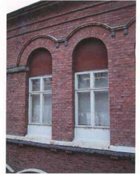
Kuva 70 E-siipirakennuksen eteläjulkisivun ikkunoita 30-luvulta. Lunetti peitetty rappauksella.
