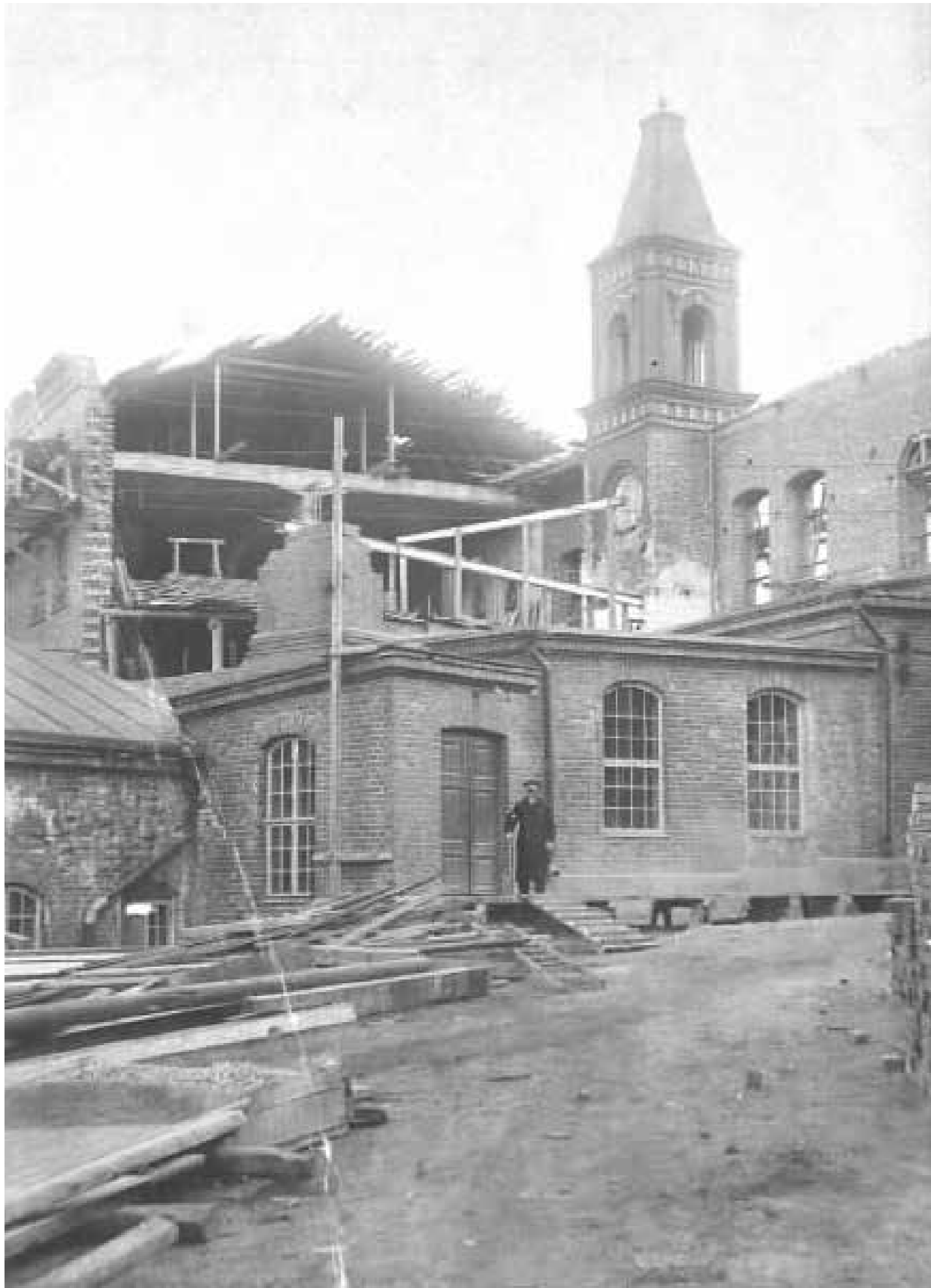
Kalanterisiiven työmaa pohjoisesta pihan puolelta. Kellotorni on säilynyt edellisestä rakennusvaiheesta.
