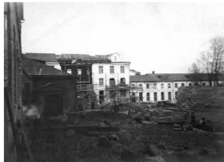
E-rakennussiiven työmaa 1900-luvun alussa. Kuvassa oikealla kivipengerrys. Numero 621:10 Lähde: Tampereen museot, kuva-arkisto
