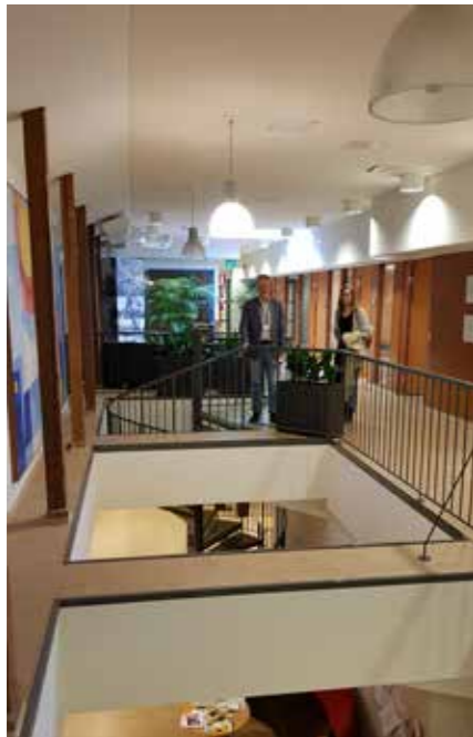
Ullakon puupilarirakenteita ja välipohjan avaukset. Hanna Lyytinen 28.5.2019, Arkkitehtitoimisto Hanna Lyytinen Oy.
