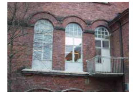
Liimatomin 2.kerroksen ikkunoita ja parveke, joita on muokattu eri rakennusvaiheissa. Arkkitehtitoimisto Hanna Lyytinen Oy, 2000.
