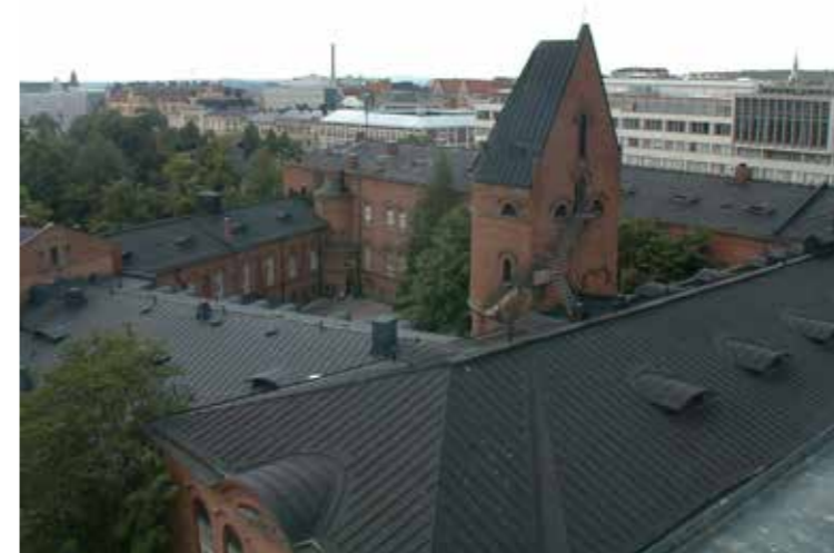
Näkymä D-siiven yli luonaaseen ennen 2000-2007 peruskorjauksta. Lähde TIKE
