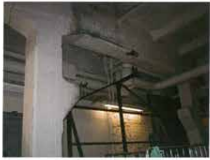
Kuva 59 Teatterin varastokellarissa esiintyy sekä kappaholvi- että rautabetonirakenteita.
