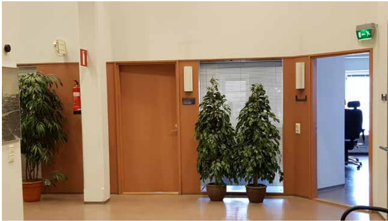
Uusia toimistohuoneiden sisäovia ja sähköpieliä. Hanna Lyytinen 28.5.2019, Arkkitehtitoimisto Hanna Lyytinen Oy.
