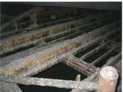
Kuvat 64, 65 ja 66 Vesitornin sisärakenteita
