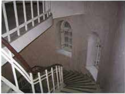
Kuvat 62 ja 63 Vesitornin kierreportaikko kaiteineen ja ikkunat ovat alkuperäiset. Askelmien pinnoite on uusi. (Federley 1904-07)
