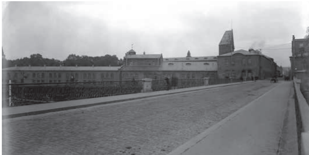
Frenckellin koskijulkisivu Satakunnansillalta vuoden 1916 Satakunnansalin korotuksen ja laajennuksen jälkeen. Veikko Kanninen, 1928. AL 181:5 D682, Tampereen museot.
