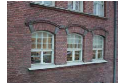
B-siiven kosken puoleisia ikkunoita kevyenliikenteen väylän pohjoispuolella. Arkkitehtitoimisto Hanna Lyytinen Oy, 2000.
