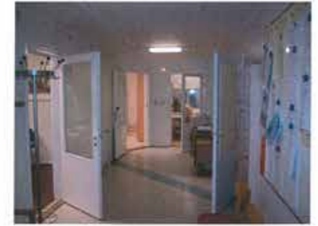
Kuva 37 Tilakeskuksen siivoustoimen 2.kerroksen toimistokäytävä etelän suuntaan.
