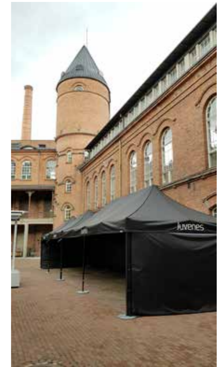
Hollanterin ullakkokerroksen korotus sisäpihan puolelta. Hanna Lyytinen 28.5.2019. Arkkitehtitoimisto Hanna Lyytinen Oy.
