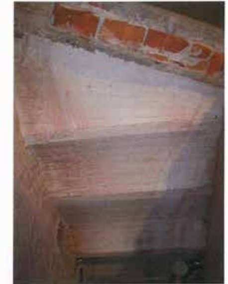
Kuva 49 Kellarin Monier-betoniholveja
