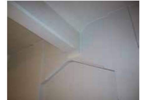
Teräsbetonirakenteita hollanterin koskenpuoleisessa toimistosiiiven 1. kerroksessa vuonna 2000. Arkkitehtitoimisto Hanna Lyytinen Oy.
