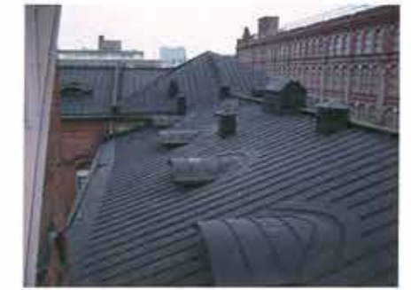
Kuva 61 D-siiven vesikatto lunetti-ikkunoineen
