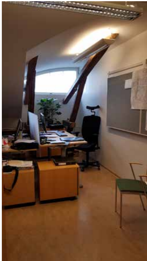
Kalanterin 5. eli ullakkokerros, uusi lunetti-ikkuna toimistohuoneessa. Vanhat puiset kattokannakkeet ovat näkyvissä. Hanna Lyytinen 28.5.2019, Arkkitehtitoimisto Hanna Lyytinen Oy.
